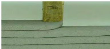
Рисунок 3. Процесс укладки материала.
